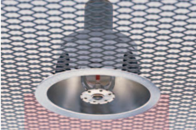
Bei den zurückgesetzten Undercover-Sprinklern schließt der Sprühteller nahezu deckenbündig ab.
