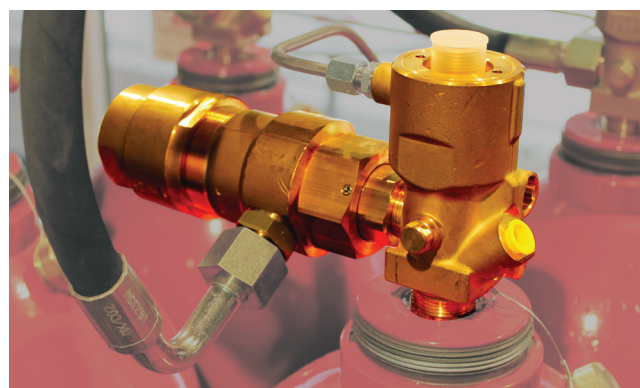
Zawór butli z wysokiej jakości regulatorem ciśnienia używany w technologii Oxexo ConstantFlow
