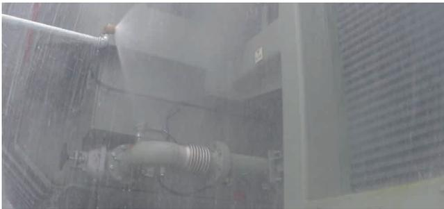
zugelassene Einrichtungen wie Kiesschüttungen oder flammendurchschlagsichere Abdeckungen geschützt ist, werden zusätzlich TraFoProtect Düsen Typ C im Bodenbereich installiert.
