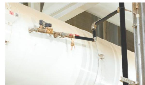
Fendium Rohre der Basic Serien sind ausschließlich für den Einsatz in Nass-Rohrnetzen von Sprinkleranlagen bestimmt.
