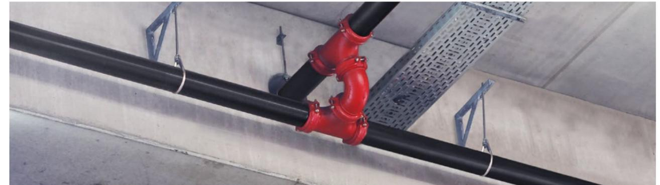
Mit Edelstahlrohren ließe sich Korrosion in Wasser-Löschanlagen weitestgehend vermeiden, aber aus Kostengründen werden sie hier kaum eingesetzt.
