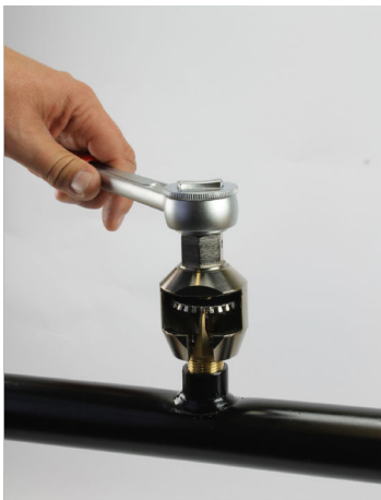
Abb. 6: Sprinklernuss (links) bzw. Sprinklerschlüssel (rechts) auf den Sechskant setzen
