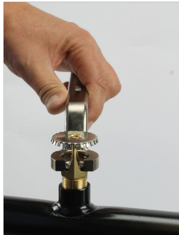
Abb. 5: Sprinklernuss (links) bzw. Sprinklerschlüssel (rechts) ansetzen
