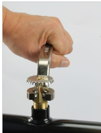
Abb. 6: Sprinklernuss (links) bzw. Sprinklerschlüssel (rechts) auf den Sechskant setzen
