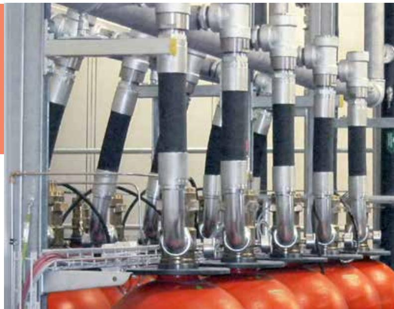
Les systèmes d'extinction MX 200 peuvent aussi bien constituer une installation à zone unique, pour la protection d'une seule zone, qu'une installation multizones, pour la protection de deux ou plusieurs zones d'extinction.
