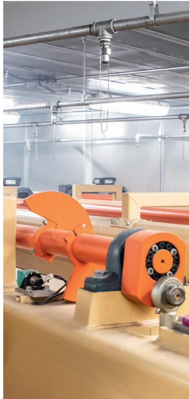
WoodTechProtect kombiniert Brandmelde-, Wassernebel- und Funkenlöschtechnologie miteinander. Der Brandschutz von Holzbearbeitungsmaschinen erfolgt durch Minifog ProCon Wassernebel-Löschanlagen während
