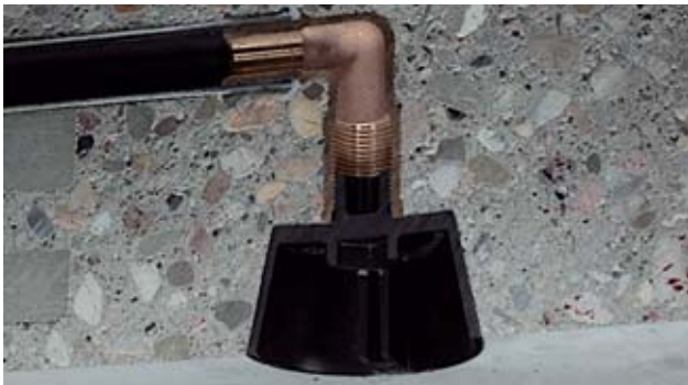
Einbetoniertes Undercover-Sprinklerrohrsystem – noch mit Betonierhilfe versehen
